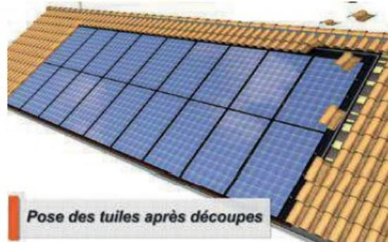
Il peut s'avérer nécessaire de redécouper les tuiles pour assurer un recouvrement efficace et conforme aux DTU. Veiller à ce que ces éléments soient obligatoirement fixés mécaniquement tel que décrit dans les DTU couverture.
