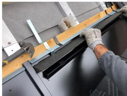
**Figure 40 – Éléments du kit TN-1 mis en œuvre**
