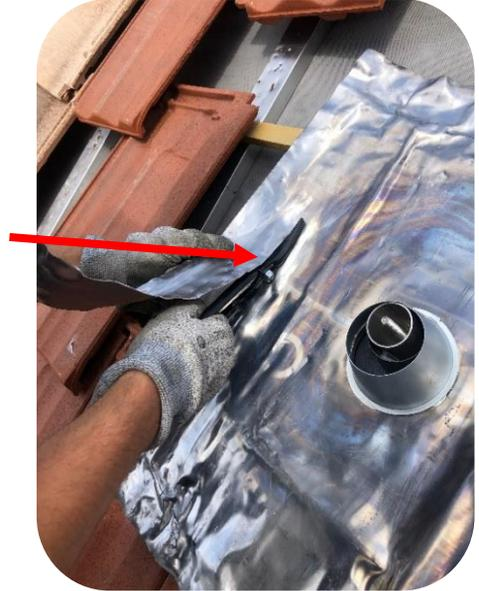
**NB2** : ATTENTION À BIEN RESPECTER LE SENS DE RECouvreMENT DES TUILES POUR LE MAROUFLAGE DE LA TUILE PLOMB
