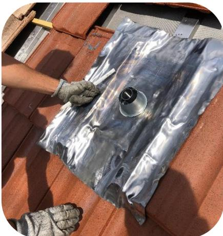
**D. RÉALISER UNE PINCE EN PARTIE HAUTE DE LA TUILE PLOMB POUR ASSURER L'ÉTANCHÉITÉ DE L'ENSEMBLE**
