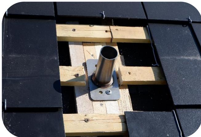
**NB1** : LE PLOT DOIT ÊTRE FIXÉ SUR LE CHEVRON À L'AIDE DE 2 VIS Ø8MM OU 4 VIS Ø6MM (FOURNIES) OU DE 2 VIS Ø8MM (NON FOURNIES)
