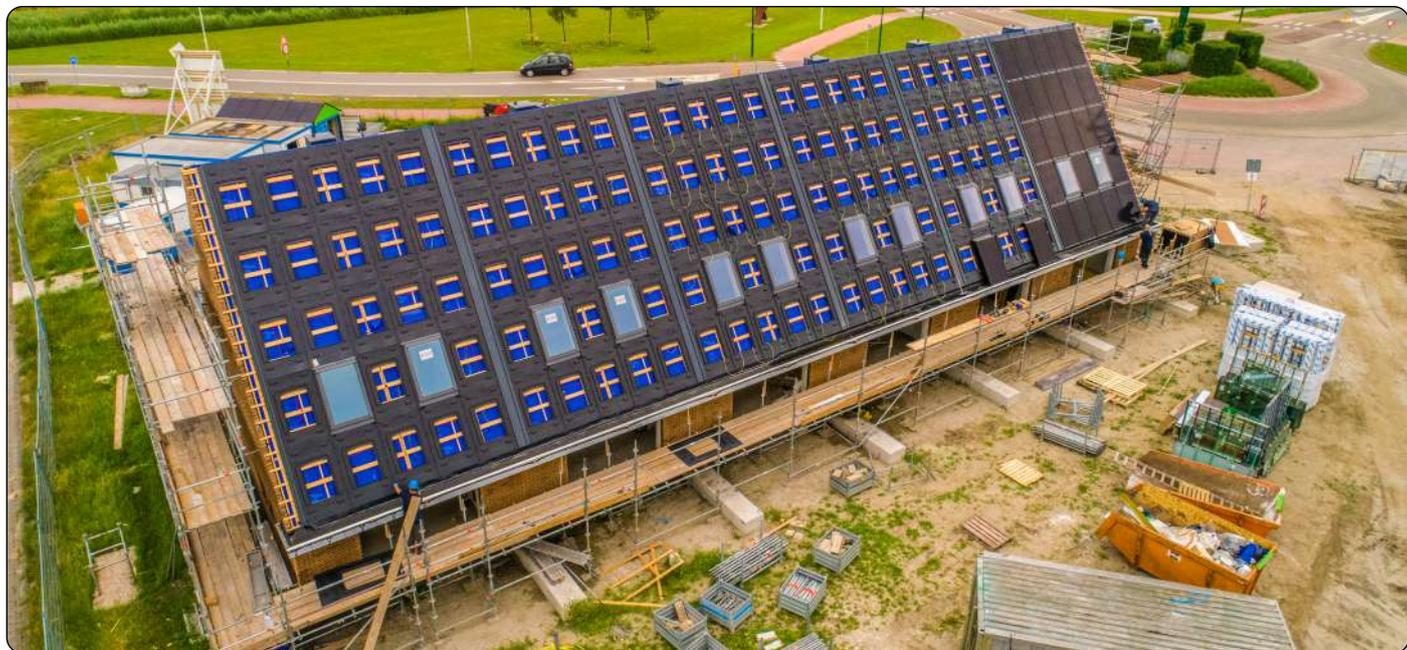
Depuis plus de 10 ans, **GSE Intégration** a mis au point un système de montage IN-ROOF qui permet de réaliser une toiture solaire avec des modules photovoltaïques standards.
