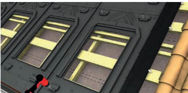
Schrauben der Wannen-Befestigungspunkte
