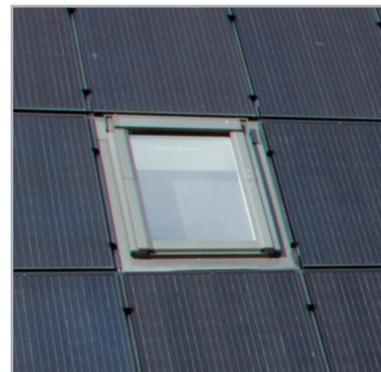
**3. Intégration parfaite des fenêtres de toit et panneaux PV**
